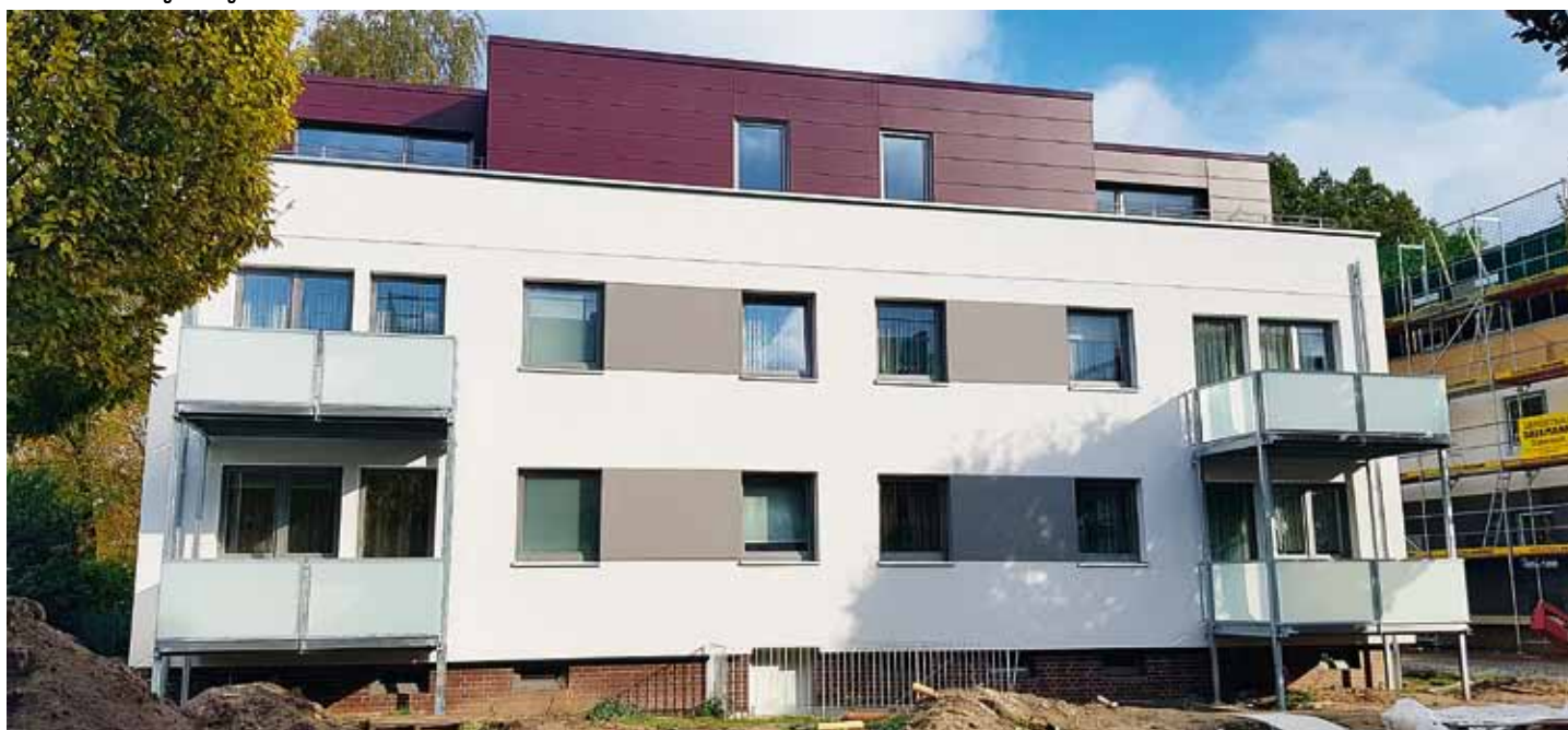
Gebäude nach Fertigstellung
