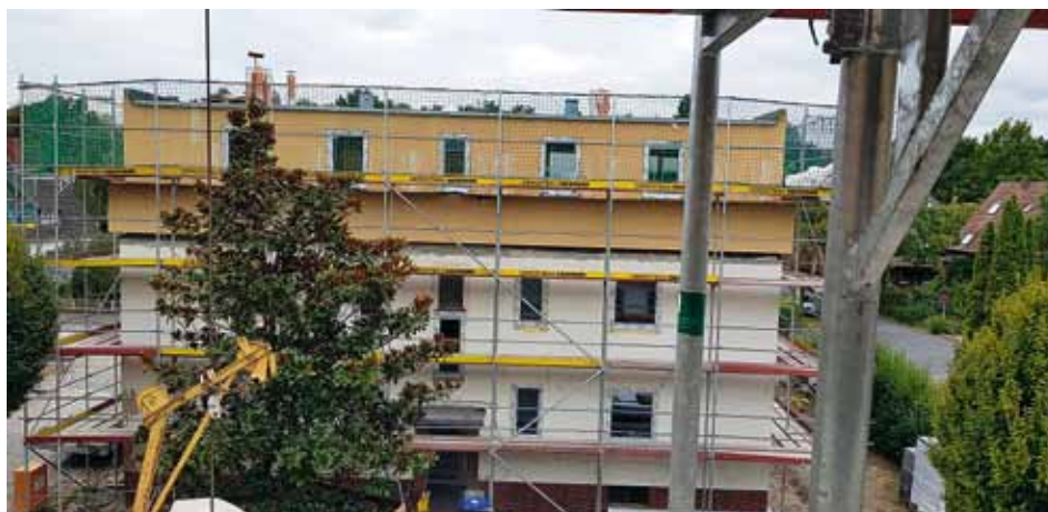
Aufstockung in Arbeit
